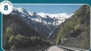
北アルプス大橋
